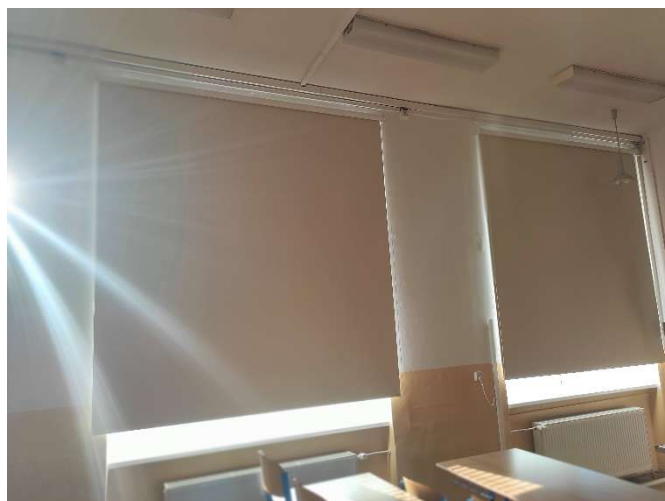
Renovace zatemňovacích rolet - 4 kmenové třídy
