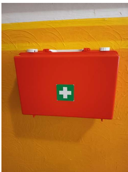
Instalace lékárniček na chodby – 4ks
