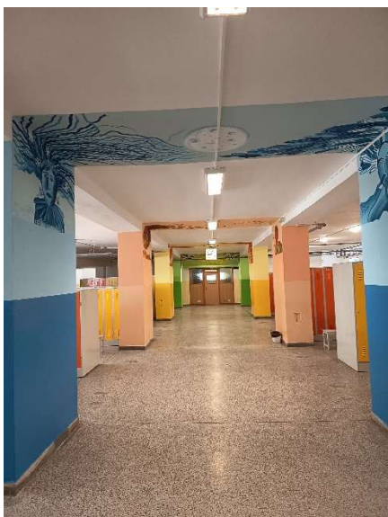
Malování šaten, oprava soklu
